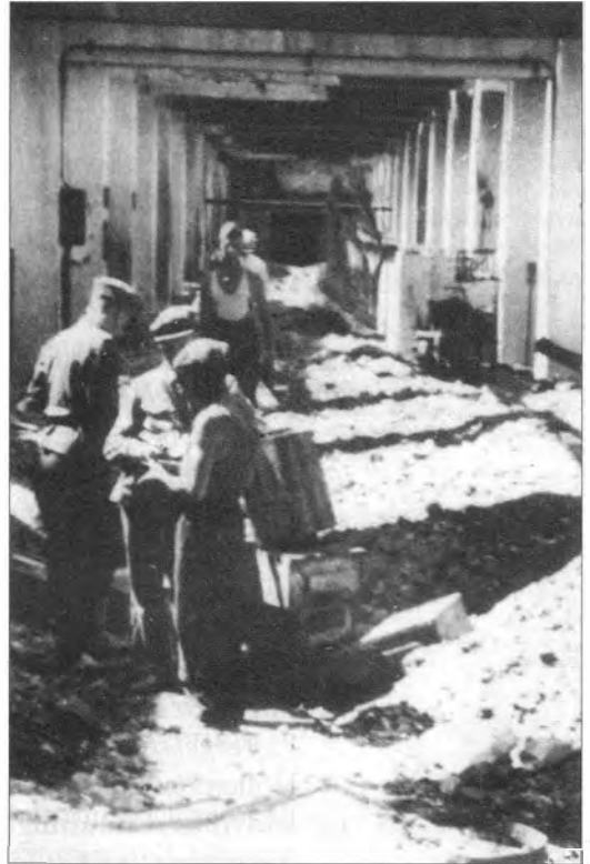
Zugzünder sind bereits entschärft, 25 kg-Sprengstoffkisten werden hier, unter einem öffentlichen Großgebäude, entschärft. Aus: Horst RIEBENSTAHL, Deutsche Pioniere im Einsatz , Dörfner-Nebel, Utting 2001.
